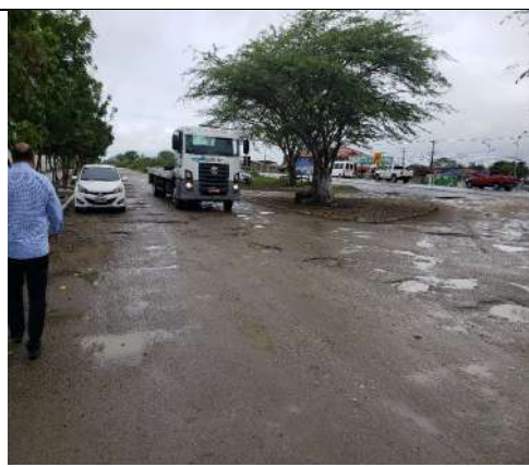
Foto 2 – Acesso lateral ao distrito (Acesso DI Queimadas)
