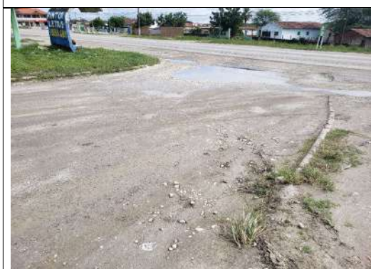
Foto 5 – Acesso da BR 104 para o distrito (Acesso DI Queimadas)
